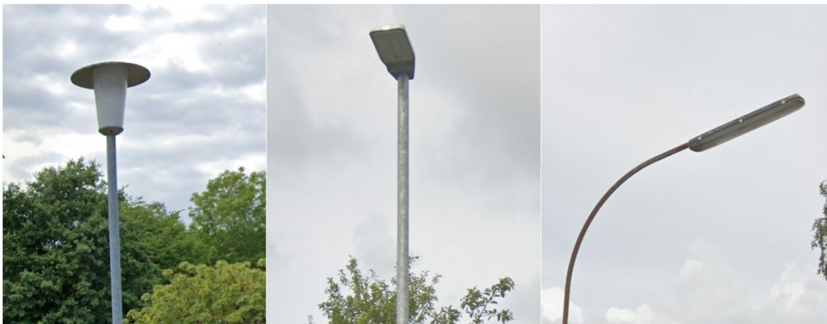
Abbildung 17: Beispielhafte Straßenbeleuchtung in Steinbergkirche (Quelle: Google Street View, 2023)
