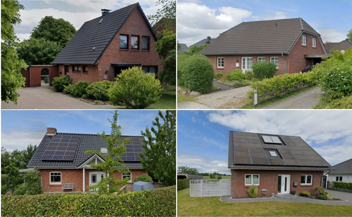
Abbildung 4: Repräsentative Beispiele für die Bebauung im Quartier (Quelle: Google Street View, 2023)
