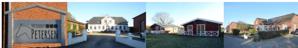
Betriebsleiterwohnhaus Ferienhäuser Bestand
