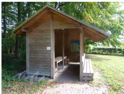
Rastplatz mit Schutzhütte am Ostseeküstenradweg
