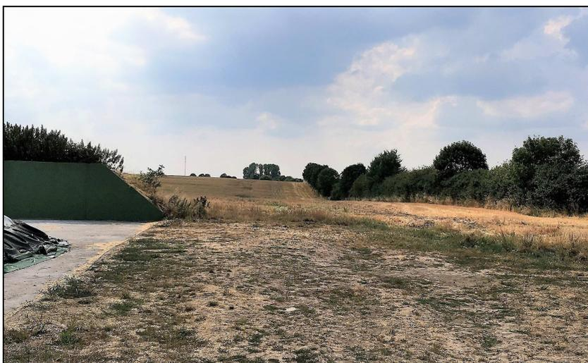
Abb.3: Silofläche mit Übergang zum Acker, durch die erhöhte Lage wird verhindert, dass Regenwasser auf die Silofläche fließt
