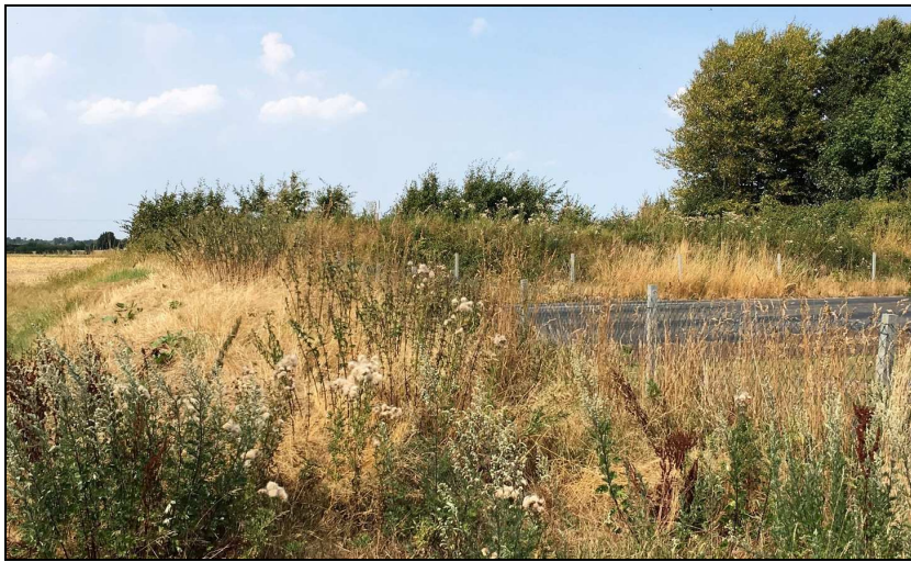
Abb.1: Sickerteich mit Verwallung, im NO ein Knick als Sichtschutz
