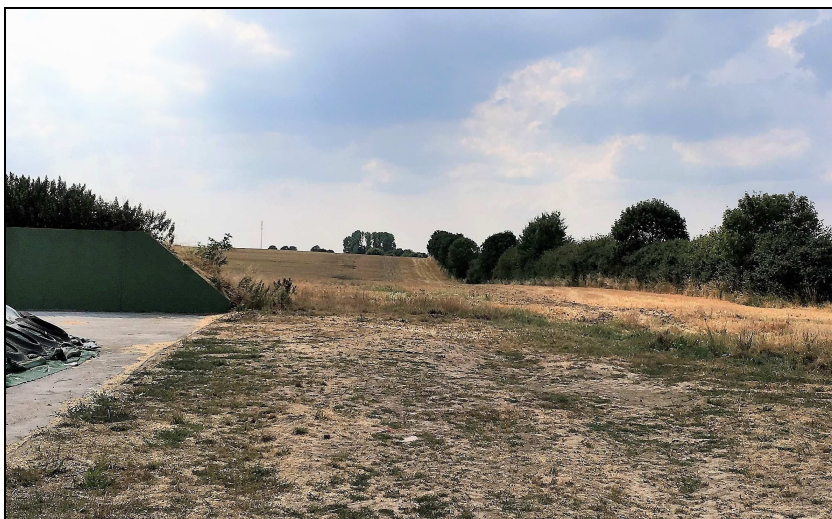
Abb.3: Silofläche mit Übergang zum Acker, durch die erhöhte Lage wird verhindert, dass Regenwasser auf die Silofläche fließt
