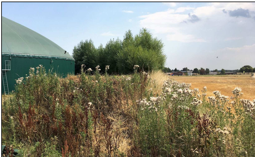
Abb.2: Knick und Verwallung der Silofläche
