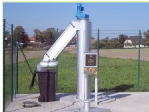
Abb. 11 und 12: Siebrechenanlage in vertikaler Aufstellung (Quelle: Huber AG)
