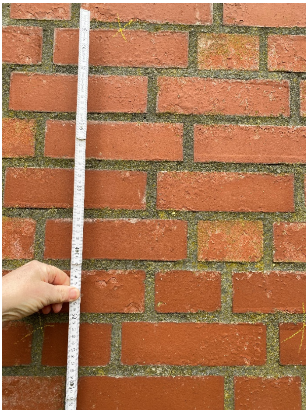
Bild 2 – Vertikaler Abstand der Verblendanker
