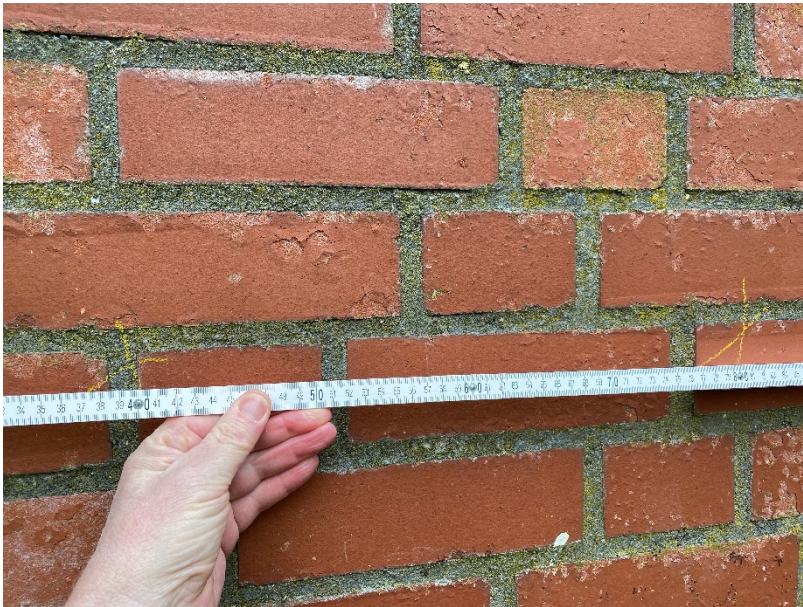
Bild 1 – Horizontaler Abstand der Verblendanker
