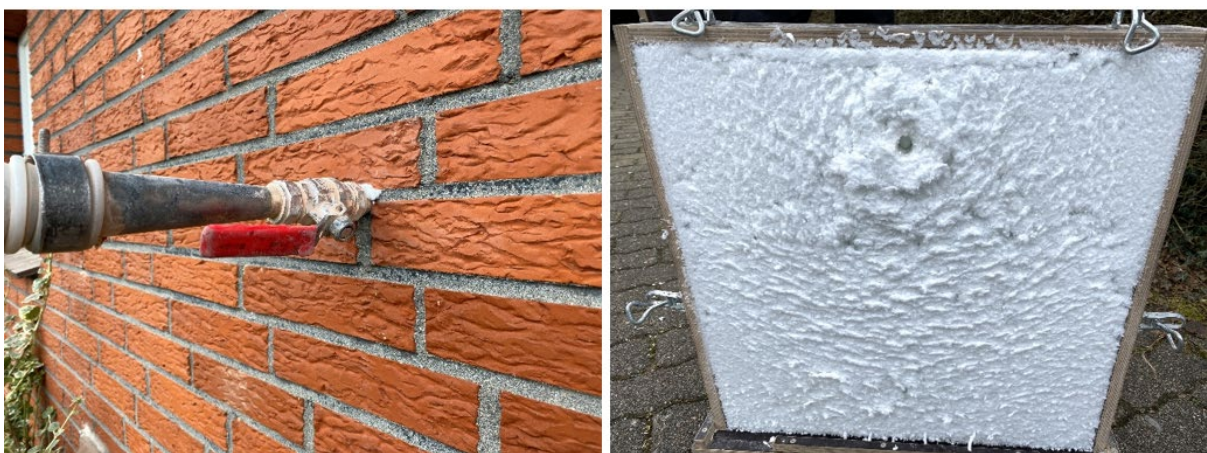
Abbildung 24: Einbringen der Kerndämmung von außen (links), Eingespritztes Dämmmaterial: Mineralfaser der Wärmeleitstufe (WLS) 035 (rechts) (Quelle: Energieberatung Asbahr)
