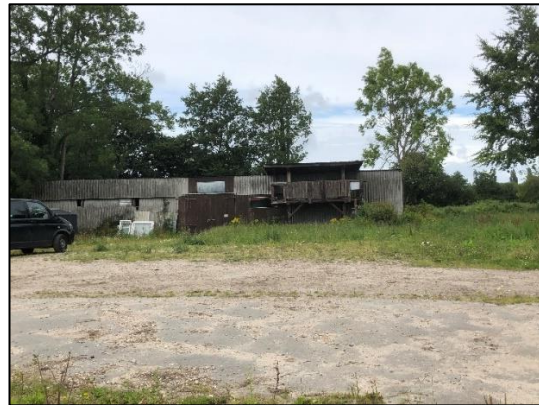
Foto 2: Freifläche und Schuppen Nordosten
