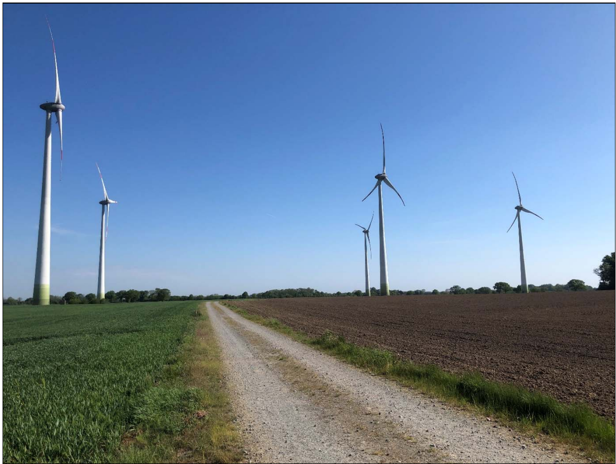
Abb.: Potenzialfläche 1, Blick nach Norden
